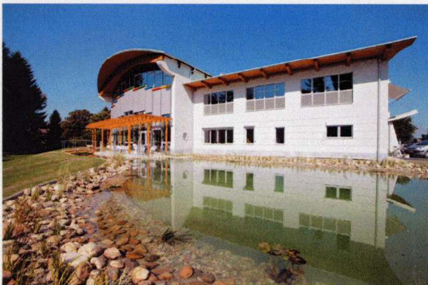
Die Raiffeisenkasse Pitten ist komplett als Niedrigenergie-Bank ausgeführt.
